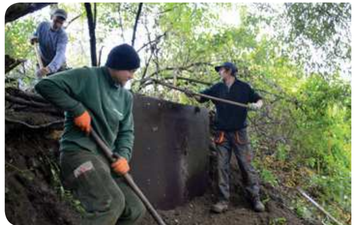
Am linksseitigen Ruhrufer gegenüber der Fischtreppe am Spillenburger Wehr und unweit des historischen Schleusenhauses befindet sich die neu errichtete Brutwand
